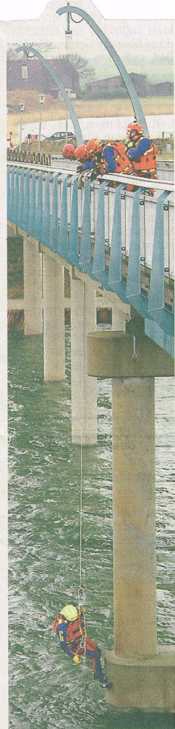
Beim Abseilen von der Brücke ist Teamarbeit gefragt.
